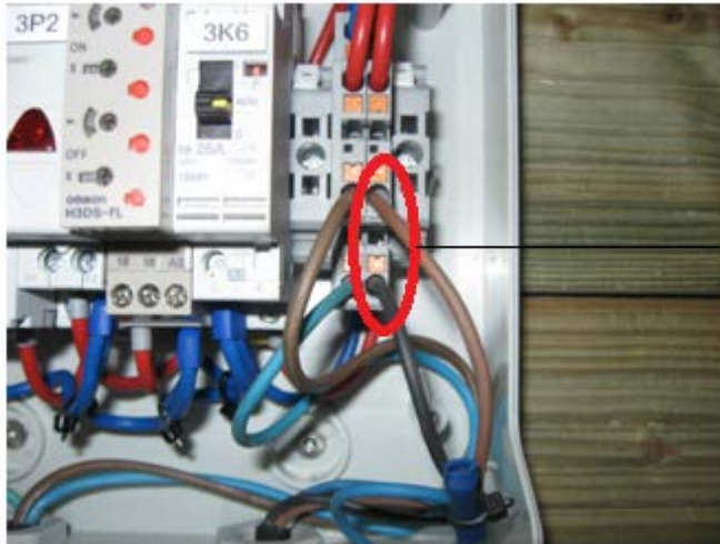
raccordement du commutateur à flotteur de trop-plein
